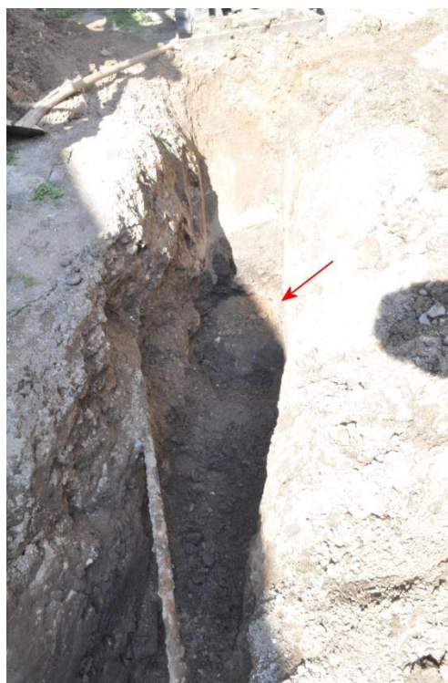
Sten (mulig syldesten) i kloakgrøft. Fig. 43
