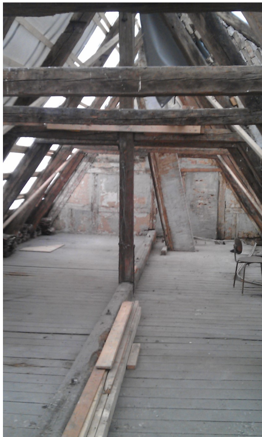
Tagkonstruktion med hængeværk
