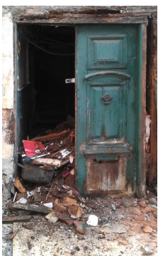
Stengade 58, indgangsdør ved renoveringens begyndelse
