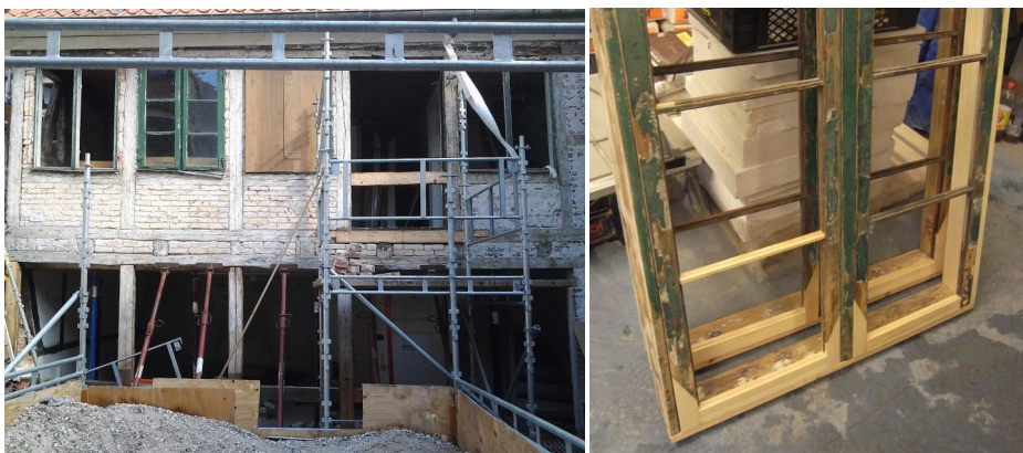
Istandsæt vindue med 'luset' ramme
