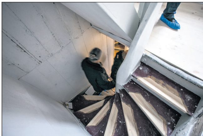
Trappen op til førstesal er også fredet. Derfor er det kun den medtagede del af trappen, der er skiftet ud, mens den øvrige del er bevaret. - Det er Helsingørs nyeste ældste trappe, fortæller Ove Kyhn.
