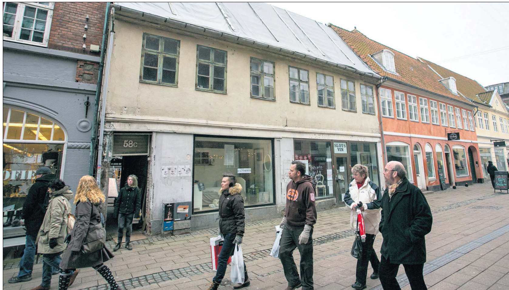
Stengade 58 set udefra. Bygningen ud mod Stengade er næste etape i det omfattende renoveringsprojekt.
